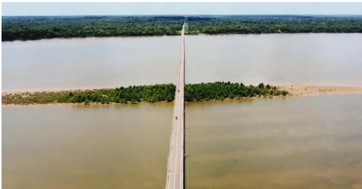
Figura 9: Ilha sob a ponte Sebastião R. de Oliveira
